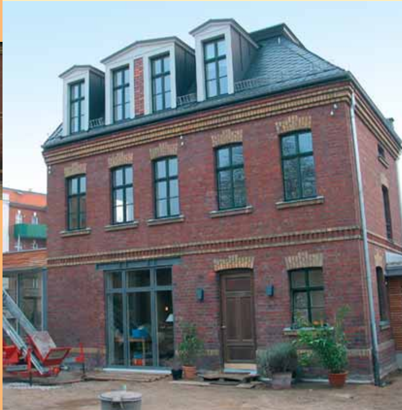
Hermannstraße 20 mit Neubau (kleines Foto) und sanierten Wohngebäude
