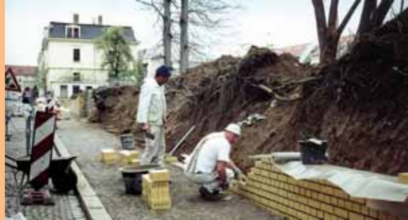
Erneuerung der Stützmauer, April 2002
