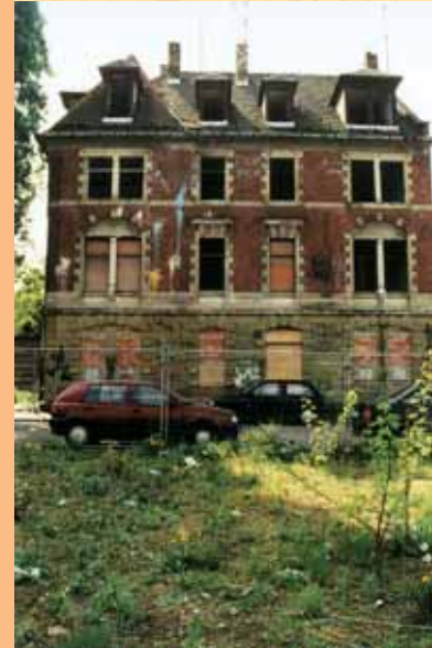
In diesem Jahr die Sanierung vorgesehen – Auerbachstraße 10
