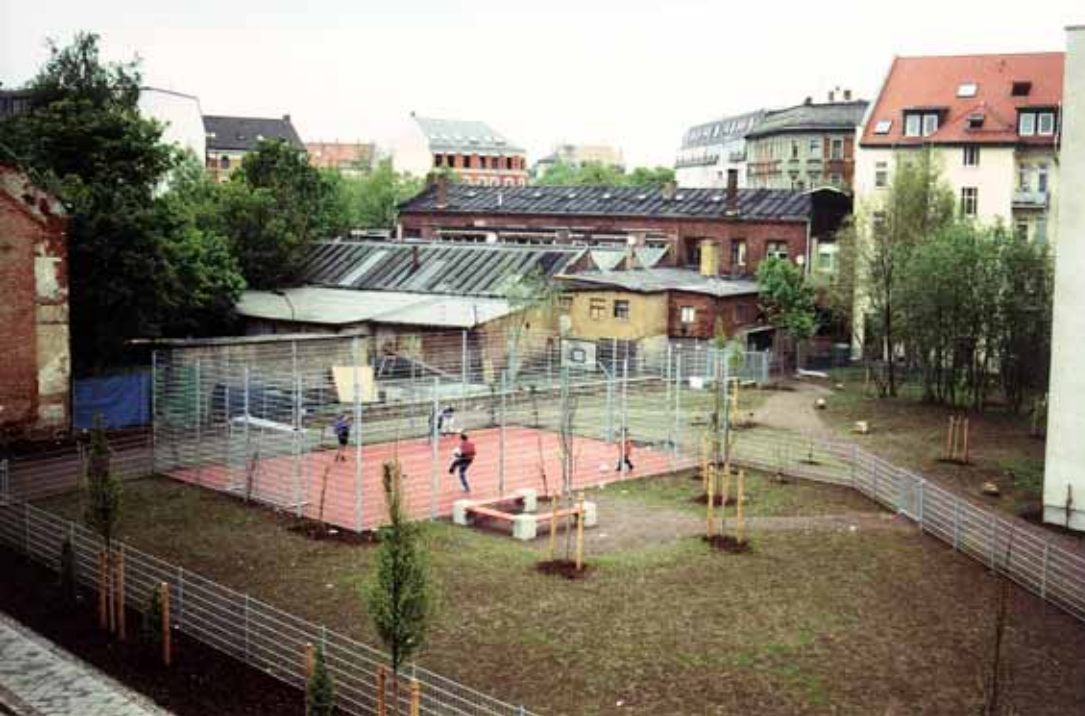
Biedermannstraße 23-29 nach der Fertigstellung, April 2002
