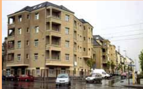
Meusdorfer Straße 1 nach der Sanierung, Frühjahr 2002
